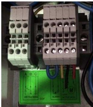
Il pannello di controllo avrà un ponte tra i contatti dell'allarme (vedi foto) che dovrà essere rimosso quando si collegherà l'allarme incendio finale con il pannello di Rilevazione centrale dell'edificio.
