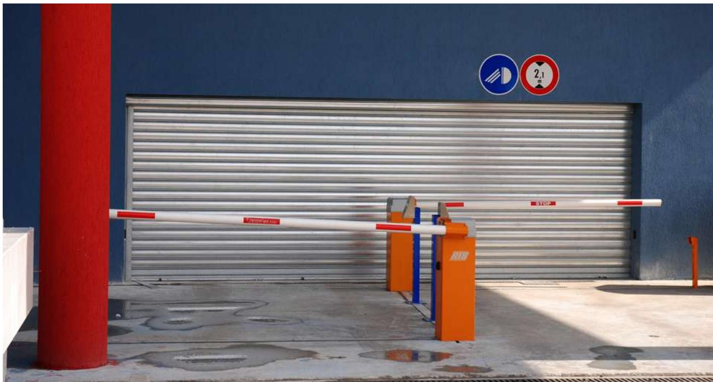
L' avvolgibile tagliafuoco **BLOCKSHUTTER E90** viene normalmente fornita con motore monofase 230 V o trifase 400 V con sistema detto Gravity fail safe, con rinvio a catena, freno che fa in modo che la serranda scenda a velocità controllata, anche in caso di mancanza di corrente e sistema di manovra manuale di emergenza a catena.
