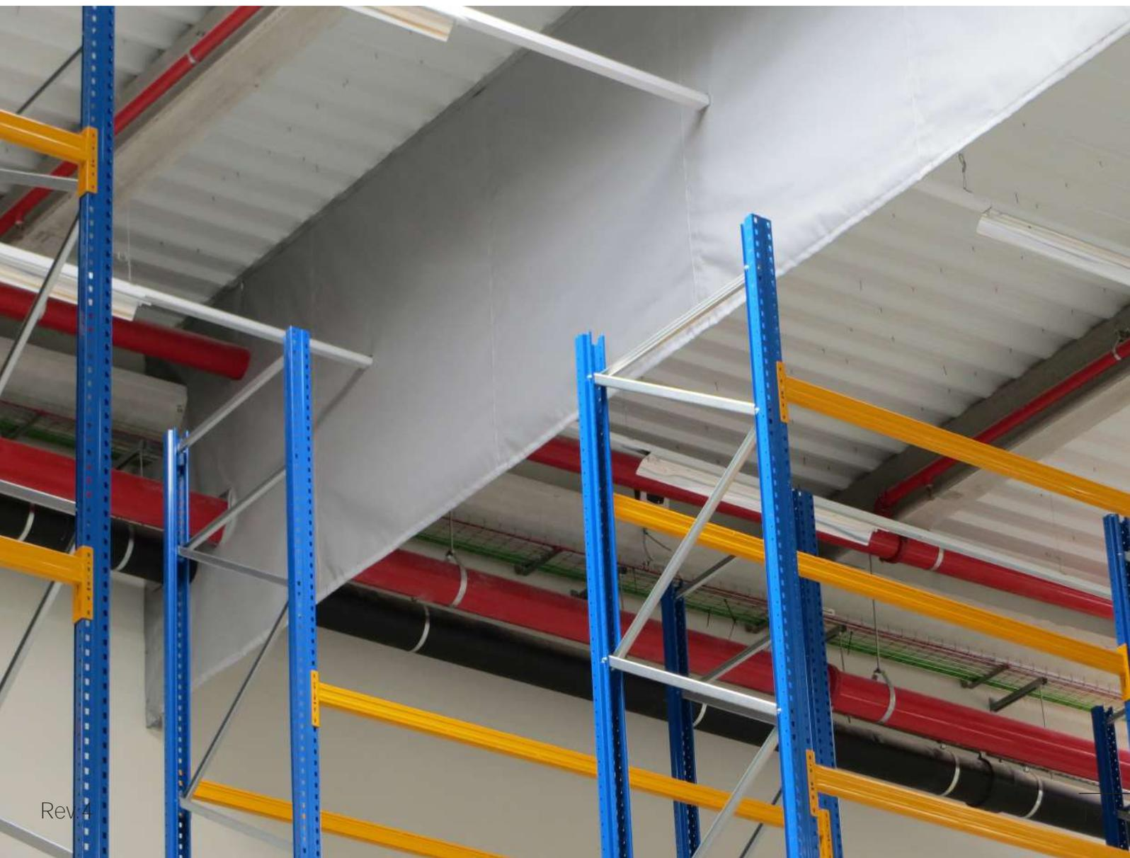
La tenda tagliafumo **BLOCKCURTAIN DA150-DH60 FISSA** è appositamente progettata per essere installata in spazi di grandi dimensioni, magazzini o centri logistici. È un sistema leggero, efficace ed economico, per aree in cui la posizione fissa della barriera non interferisce con le operazioni o le attività nei locali della sua ubicazione.
